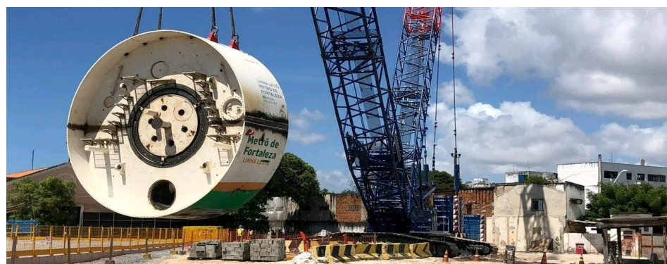
MAKRO em ação com a tuneladora do Metrô
